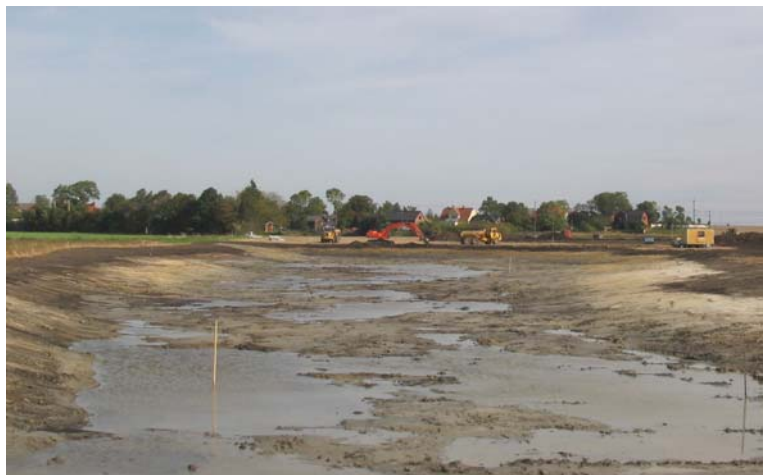
Figur 25. De flesta dammar/våtmarker i jordbruksområden måste skapas genom schaktning ner till befintliga vattennivåer. Projekt 66 vid Flädie, september 2003.
